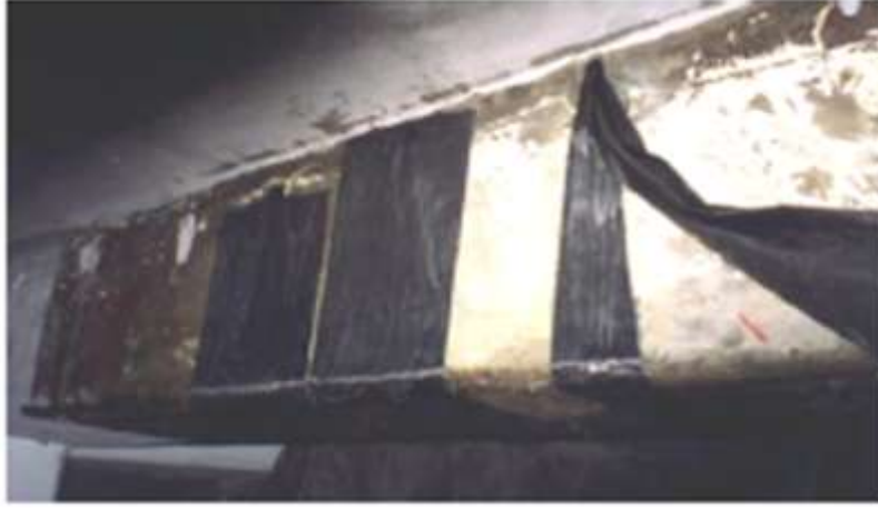
الشكل(6) الربط بشرائح ألياف الكربون لتقوية جوائز على القص.
