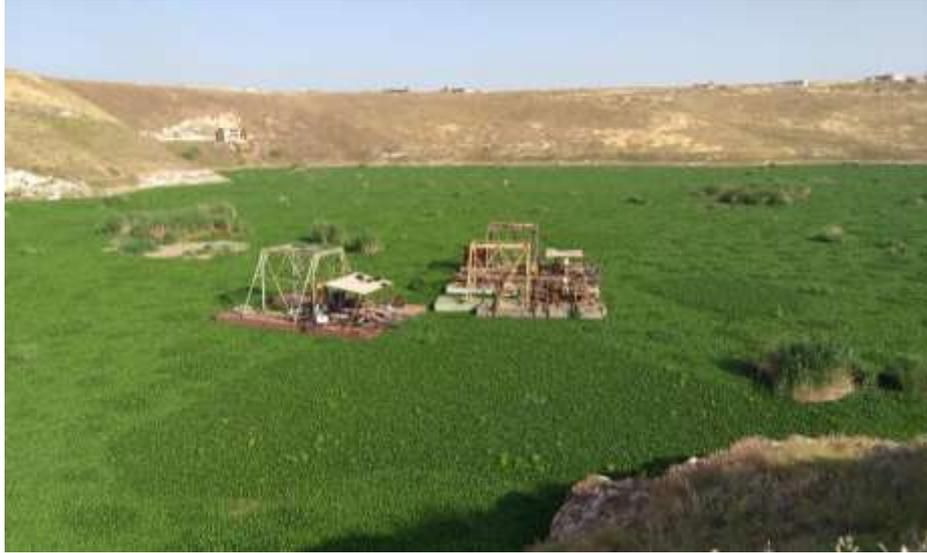
الشكل 1: زهرة النيل تغطي كامل بحيرة سد محرمة وتهدد بتوقف مجموعة ضخ المياه العائمة على سطح البحيرة التي تؤمن مياه التبريد اللازمة لعمل محطة توليد محرمة
