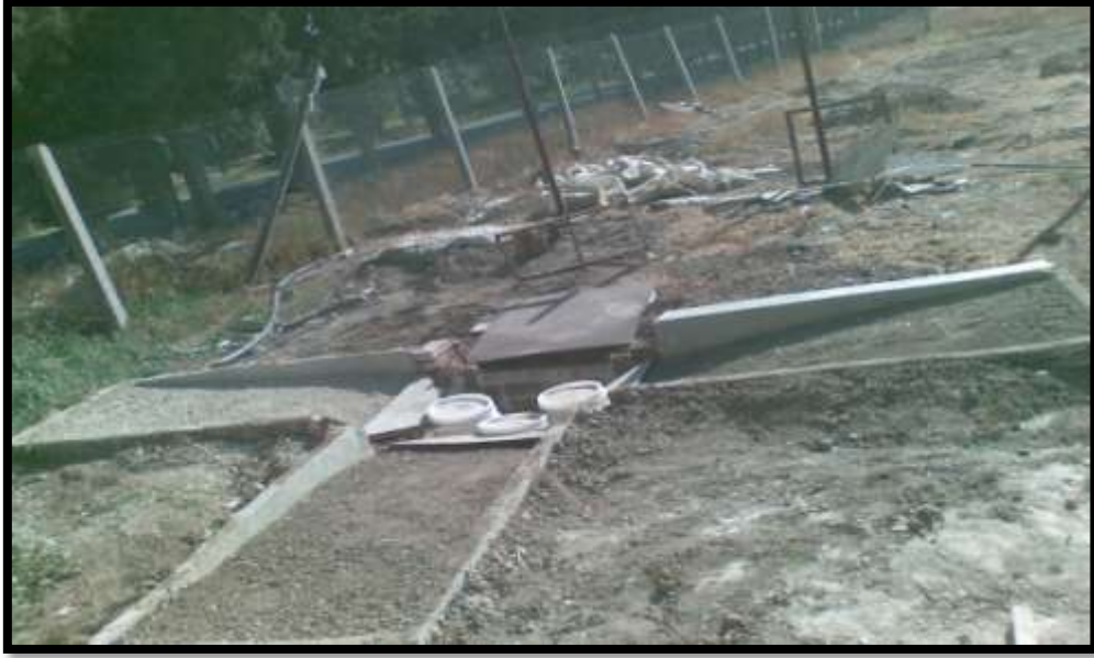
الشكل (2): الأحواض الثلاثة مملوءة بالتربة، ومجهزة لاستقبال العواصف المطرية الصناعية.
