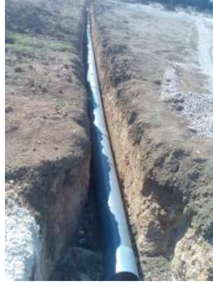
صورة (6): أنابيب الصرف الرئيسية داخل الخنادق (نقطة تصريف رئيسية، ريجار)
