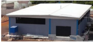
الشكل (3): سقف بألواح سندويشية لمعمل محلي
