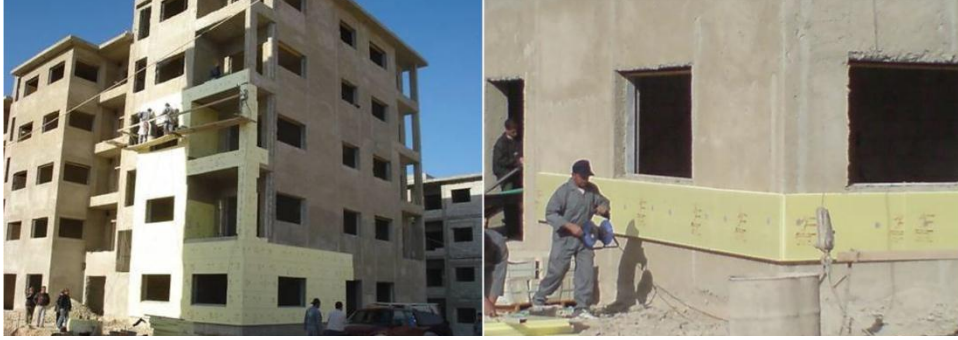
الشكل (2) صور من عملية عزل المبنى في مشروع السكن الشبابي بضاحية قدسيا، المصدر: [7]
