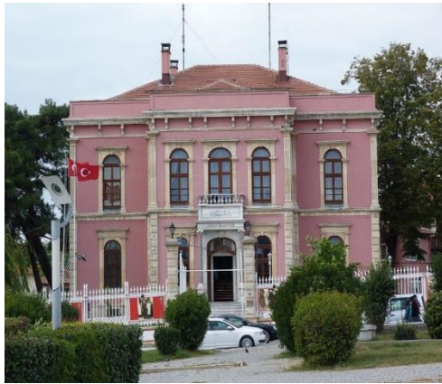
الشكل (9) الواجهة الرئيسية لدار بلدية أدرنه
