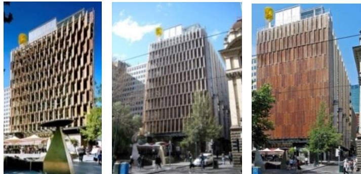
الشكل (14). آلية التكيف في غلاف مبنى Council House (شرائح عمودية من الخشب متحركة بنظام هيدروليكي لحماية الداخل من أشعة الشمس) [3].
