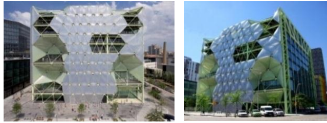
الشكل (15). آلية التكيف في غلاف مبنى Media Tic (شبكة من الوسائد من مادة ETFE تخلق الظل في حالة انتفاخها) [29].
