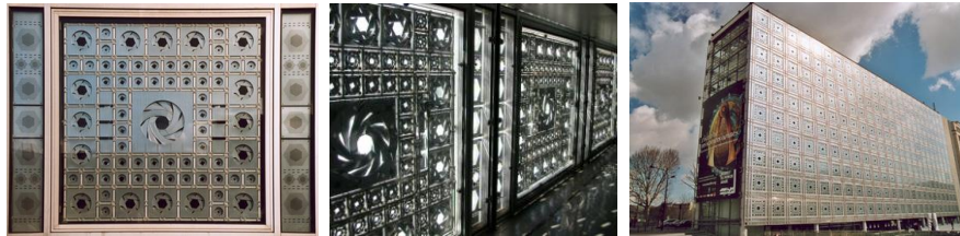
الشكل (9). آلية التكيف في غلاف معهد العالم العربي (عدسات اوتوماتيكية من الألمنيوم متحسسة للضوء قابلة للفتح والغلق) [3].
