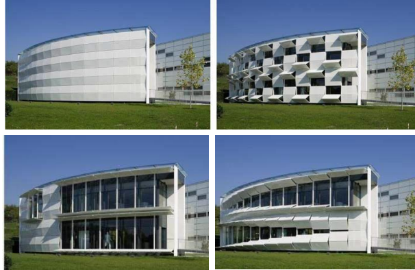
الشكل (7). آلية التكيف في غلاف مبنى شركة Kiefer technic (عناصر من الألمنيوم قابلة للطي لتظلل النوافذ الزجاجية) [31].
