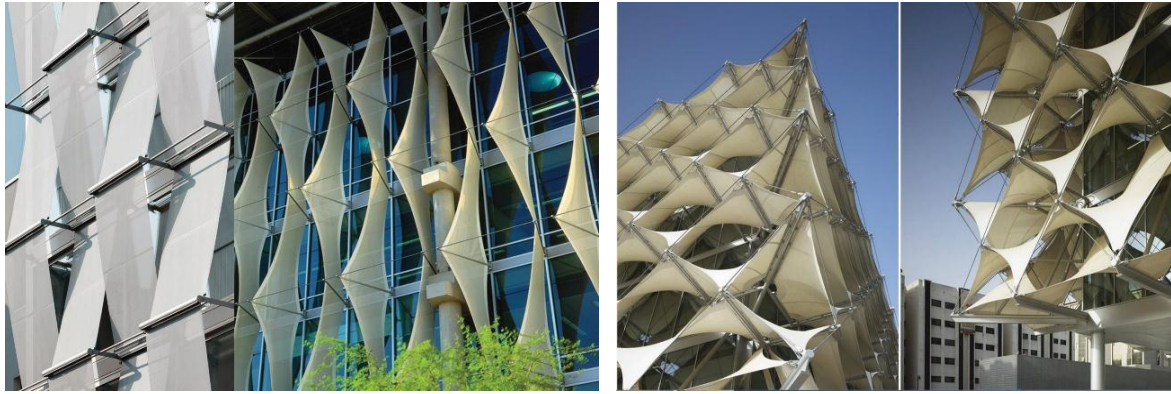
شكل (8) بعض تطبيقات هياكل الشد والتقنيات الذكية لتغليف الواجهات -تطبيق معاصر لمفهوم المشربية-
