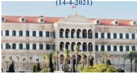
الشكل (16): مبنى السراي الكبير
