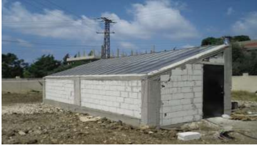
الشكل(2) المجفف الشمسي-بيت بلاستيكي في جيلة في الساحل السوري لتجفيف التبغ قبل التعديل.
