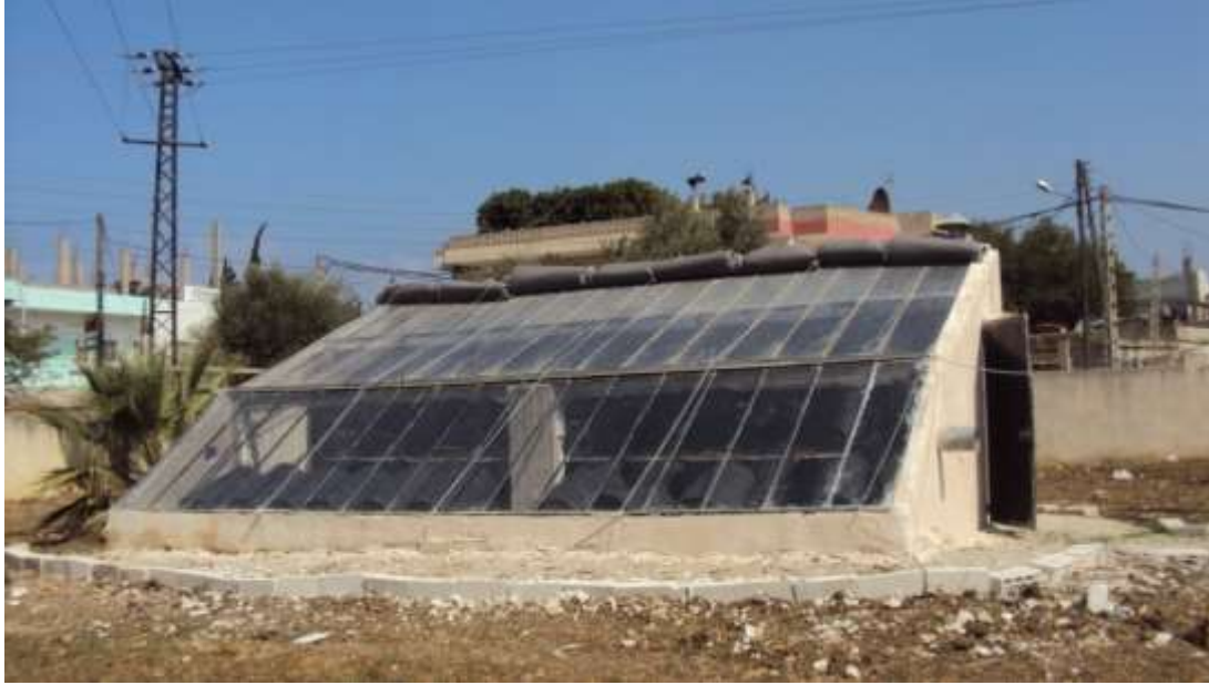
الشكل (3-a) نموذج المجفف الشمسي-بيت بلاستيكي المطور لتجفيف التبغ السوري في الساحل السوري.
