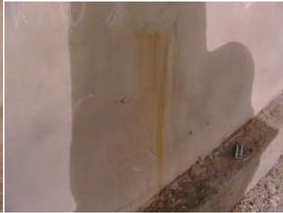
توضيح تفصيلي للشق عند الحصيرة البيتونية
