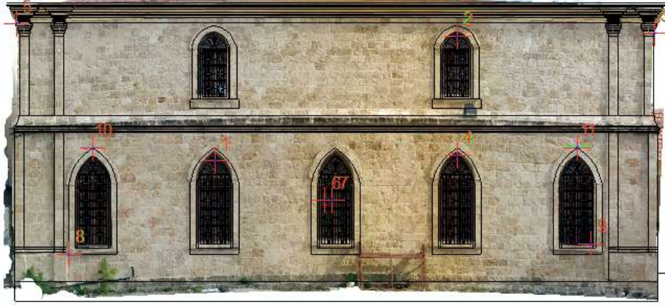
الشكل (9). توزع نقاط الضبط المستخدمة في الربط الهندسي بين الصورة المرجعة عمودياً (أورثوفوتو) للواجهة الغربية من الكنيسة الإنجيلية والمخطط المعماري لنفس الواجهة.
