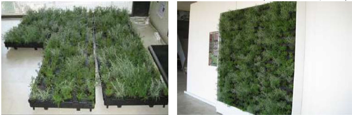
الشكل (4) طريقة تثبيت النباتات على الجدران كنظام عزل صوتي للمباني (Azkorra et al., 2015).
