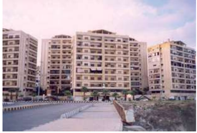
واجهة تظهر مباني النسق الأول والثاني .
