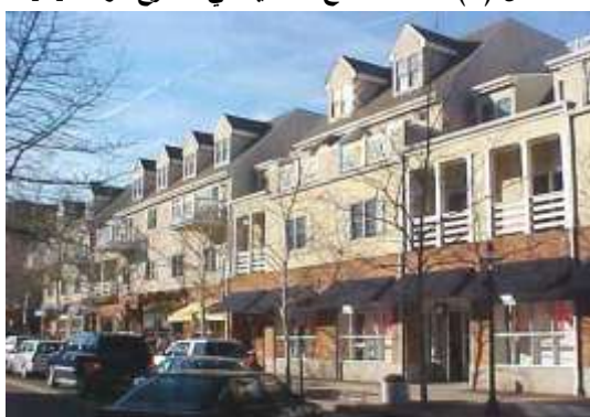
الشكل (3): انسجام المساكن مع الشارع [4].
