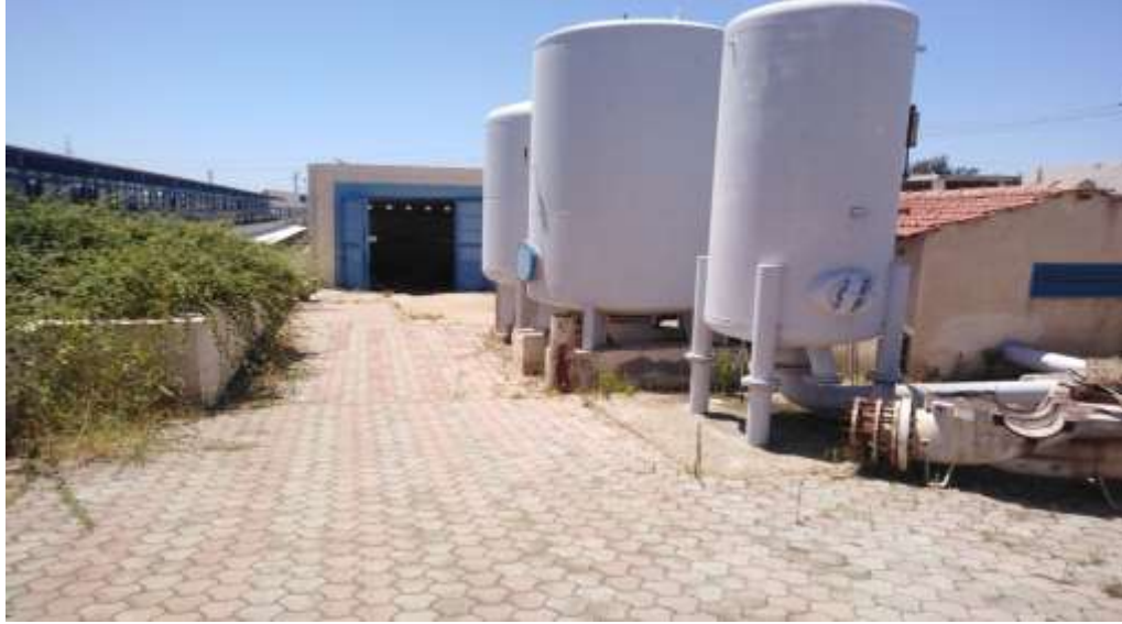
الشكل (8) يظهر خزانات المطرقة المائية على خط الجر الأول والثاني.
