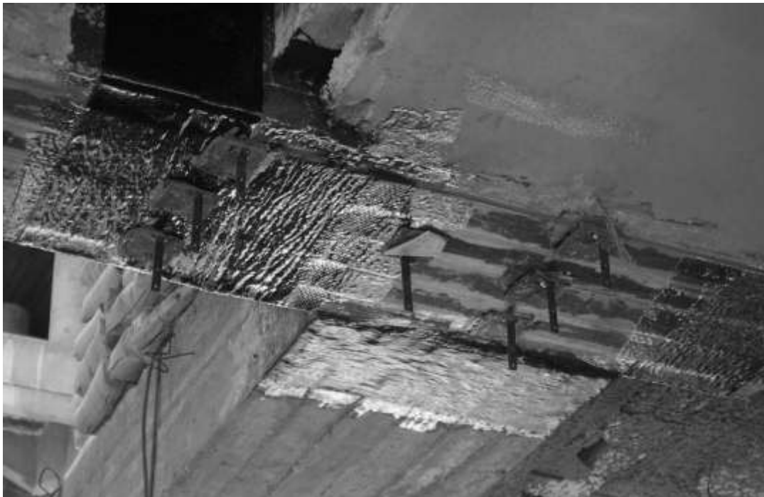
الشكل (4) طريقة تثبيت نقاط المراقبة لتركيز الميرا المقلوبة أسفل العناصر المدعمة
