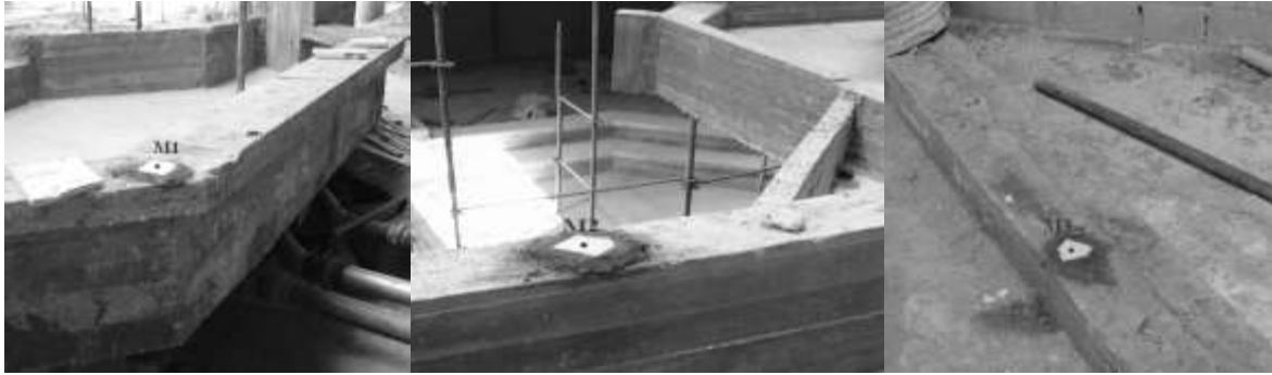
الشكل (6) النقاط المرجعية الارتفاعية M1, M2, M3
