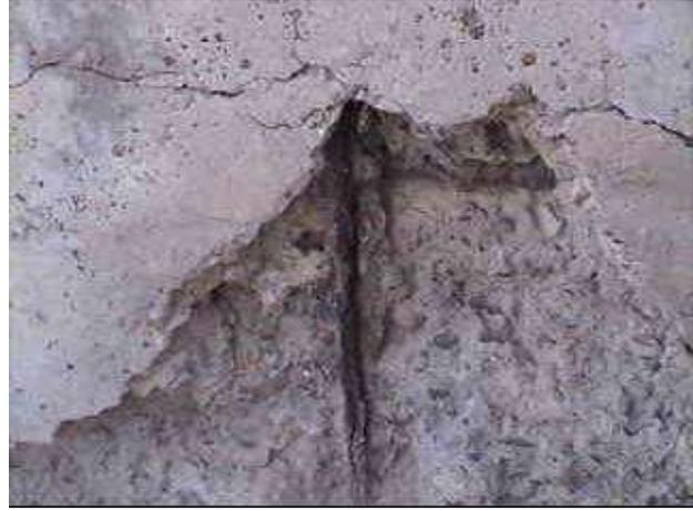
الصورة (2)، صدأ فولاذ التسليح وتشققات الخرسانة نتيجة الصدأ.
