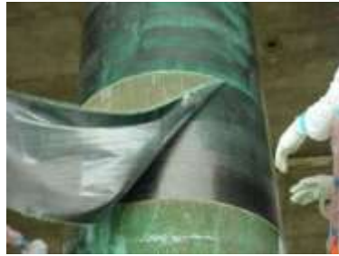
الشكل (3) التدعيم بقميص FRP (Muntasir Billah, 2011)
