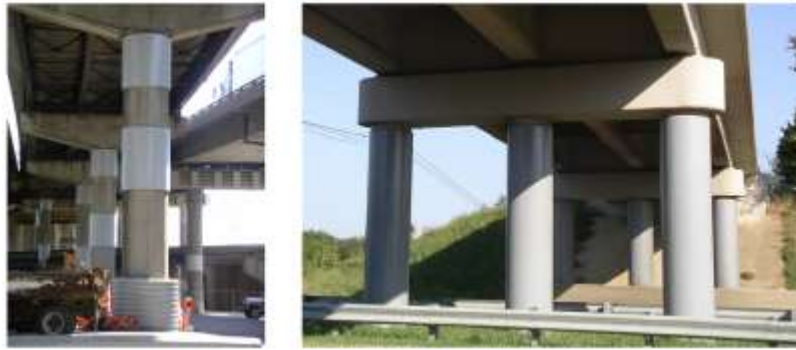
الشكل (2) التدعيم بالقميص المعدني (Padgett, 2007)
