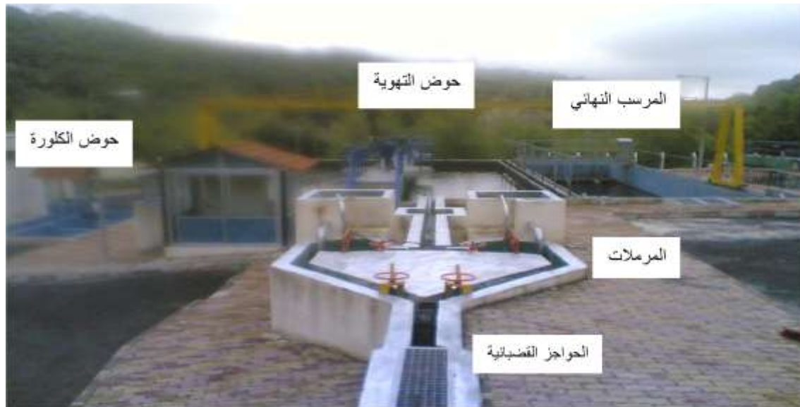
الشكل(2): منشآت محطة معالجة مياه مرج معيربان
