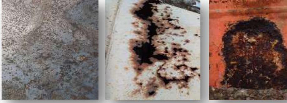
الشكل 1 بعض أشكال التآكل في الخرانات النفطية
