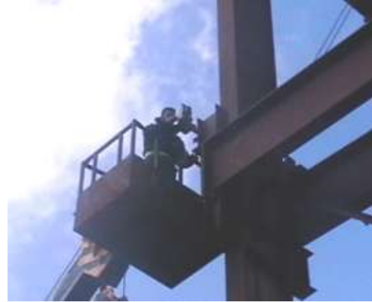
الشكل (6) التمرکز والقياس على طرف سكة الرافعة
