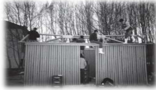
الشكل (7) مأوى مؤقت تقليدي مؤلف من ألواح التوتياء مع هيكل معدني بسيط المصدر: https://archnet.org
