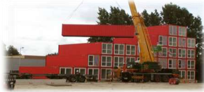
الشكل (14) آلية تجميع الوحدات المسبقة الصنع وإعدادها كحل بديل للسكن التقليدي. المصدر: prefabcosm.com
