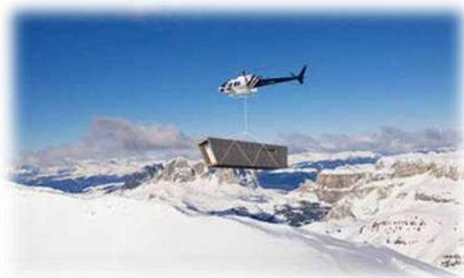
الشكل (2-3) نقل الوحدات المسبقة الصنع بالمروحيات المصدر: www.misfitsarchitecture.com
