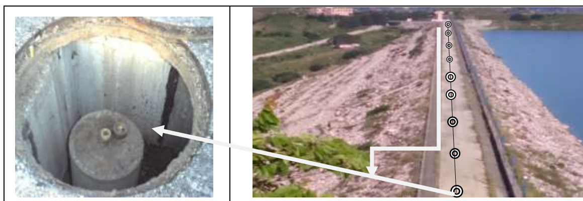
الشكل (5) شكل نقطة المراقبة الأفقية والارتفاعية في المصطبة العلوية في سد الثورة
