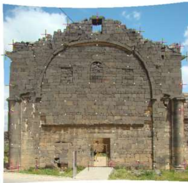
الشكل (7). تشوه الصورة عند تطبيق التحويل من الدرجة الثالثة والنمط الطرفي لتوزيع نقاط الضبط.
