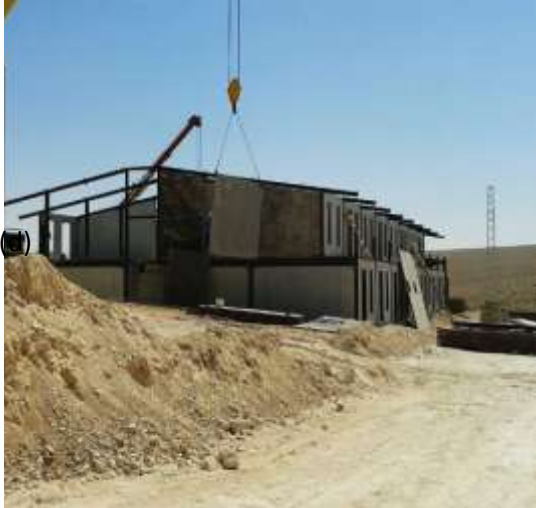
الشكل (13) تجميع وتركيب الهيكل المعدني للمبنى المتصل "الفندق المحمول" تجميع العناصر في الموقع. (a) - تركيب الهيكل الحامل، (b), (c), (d) - تركيب الجدران والأسقف
