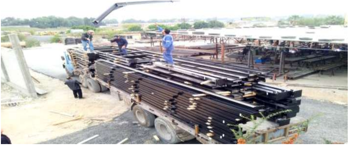
الشكل (12) نقل الهيكل المعدني للفندق المحمول في سيارة واحدة
