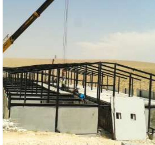
الشكل (13) تجميع وتركيب الهيكل المعدني للمبنى المتصل "الفندق المحمول" تجميع العناصر في الموقع. (a) - تركيب الهيكل الحامل، (b), (c), (d) - تركيب الجدران والأسقف
