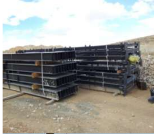
الشكل (12) نقل الهيكل المعدني للفندق المحمول في سيارة واحدة
