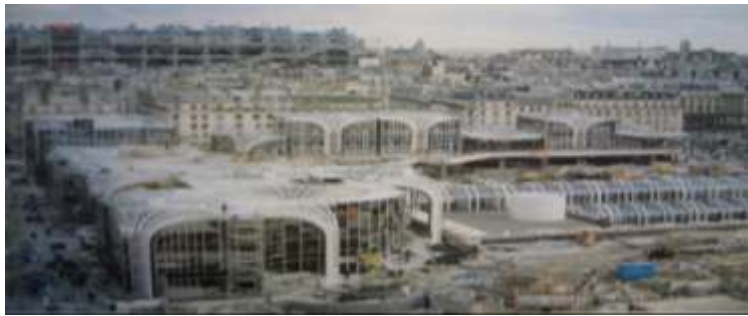
الشكل / 3 / صورة قديمة للمبنى أثناء تنفيذه يظهر في عمق الصور مركز بومبيدو الشهير.
