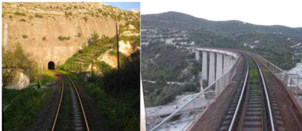
الشكل رقم (3) : صورة فوتوغرافية للخط الحديدي (الجسر ٧) والنفق 4 في نفس المنطقة.
