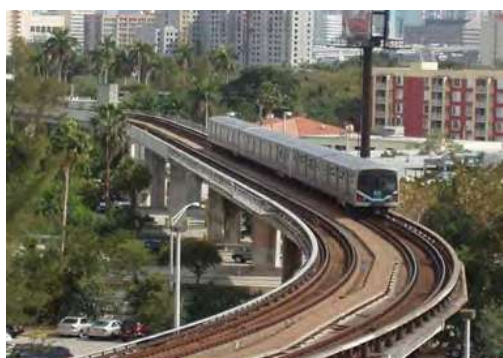
(الصورة 2 خط السكة الثقيلة في ميامي، المصدر Florida
