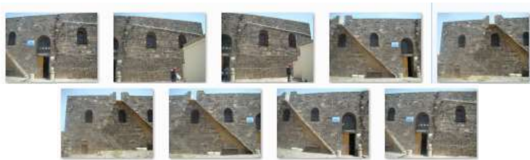
الشكل (8). صور واجهة المنشأ.
