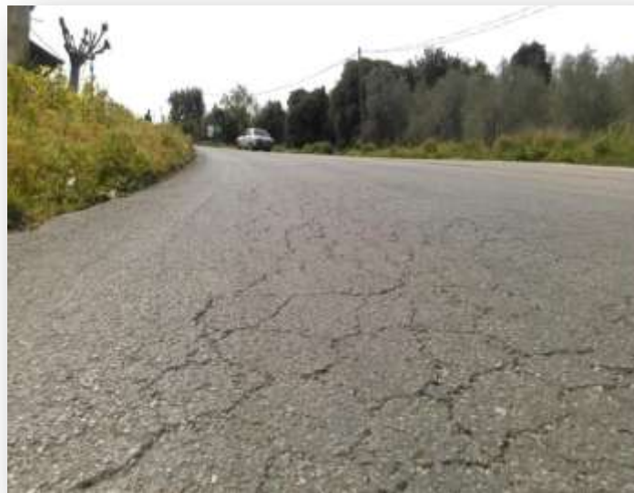
الشكل رقم (4) : شقوق طوليه عالية الشدة و حفر في القطاع 16 - 0100 - S5253
