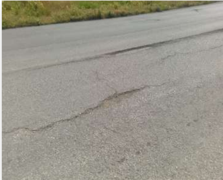
الشكل رقم (4) : شقوق طوليه عالية الشدة و حفر في القطاع 16 - 0100 - S5253
