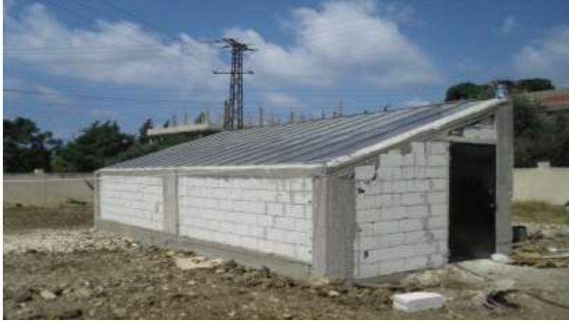
الشكل (3) المجفف الشمسي-بيت بلاستيكي في جبلة الواقعة على الساحل السوري لتجفيف التبغ.
