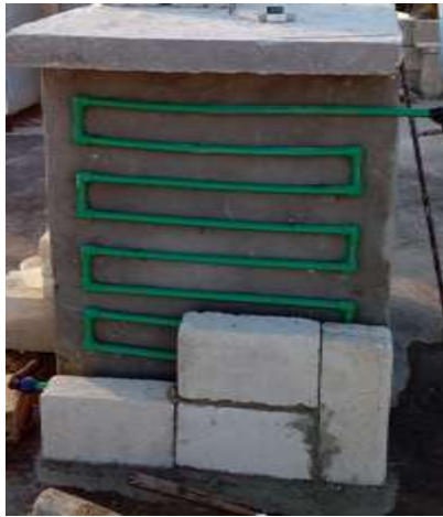
الشكل (5) تشييد الغرفة ذات الجدار الخازن للحرارة (تركيب الأنابيب)
