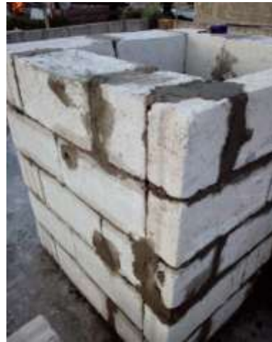
الشكل (4) تشييد الغرفة ذات الجدار الخازن للحرارة (بناء)
