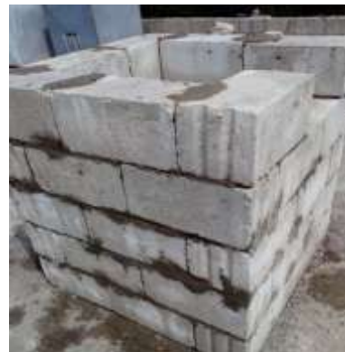
الشكل (2) تشييد الغرفة المرجعية (بناء)
