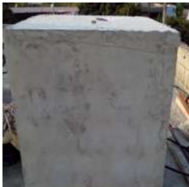
الشكل (3) تشييد الغرفة المرجعية (إكساء بالمونة الاسمنتية)
