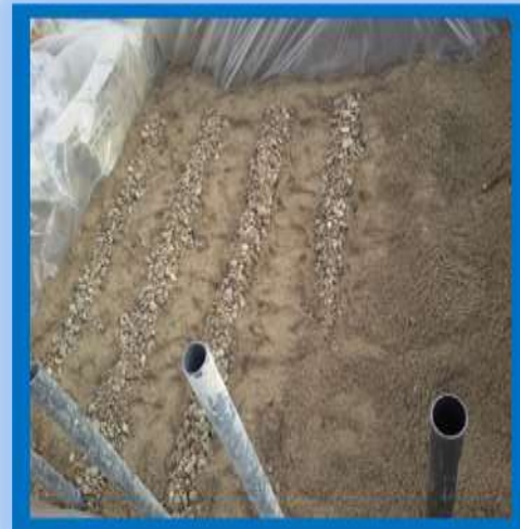
الشكل (4) توضع طبقات الرمل
