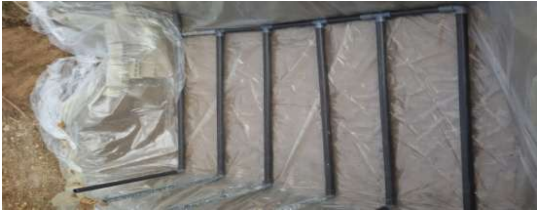
الشكل (2) عزل الحفرة وإنشاء شبكة الدر يناج
