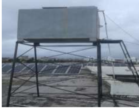
الشكل (6) يبين توضع خزان الماء البارد على قاعدة مرتفعة
