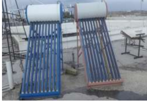
الشكل (5) يبين توضع السخائين الشمسيين على السطح
