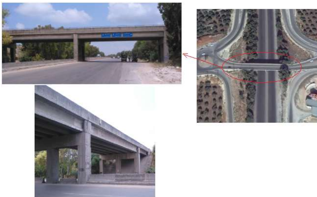
الشكل (5) صورة توضح الجسر (الخريبات - أوتستراد اللاذقية طرطوس)
