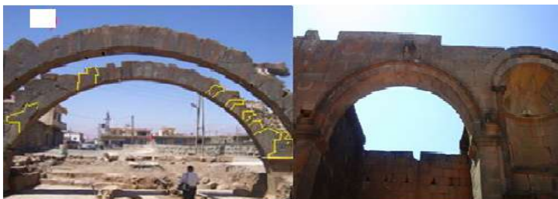
الشكل (3): يوضح تركيب الأقواس المتمفصلة.
