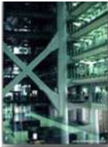
الشكل (4) الفناء المغطى في بنك هونج كونج، نلاحظ الوحدة الفراغية الرأسية والأفقية بين الفناء الداخلي والفناء المحيط به على مستوى طوابق المبنى، [ 8 ]
