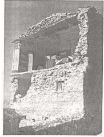
شكل (1): ضعف الأبنية الحجرية لمقاومة الزلازل (زلزال كامبانيا 1980 إيطاليا) [3]
