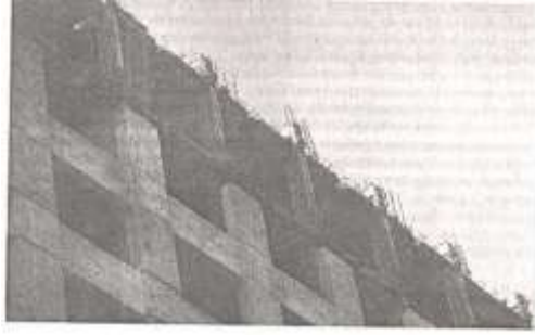
شكل (10): تقوية بناء إطارى عن طريق إحاطته بجملعة من جدران القص (القصر العدلى في مكسيكو) [14]
