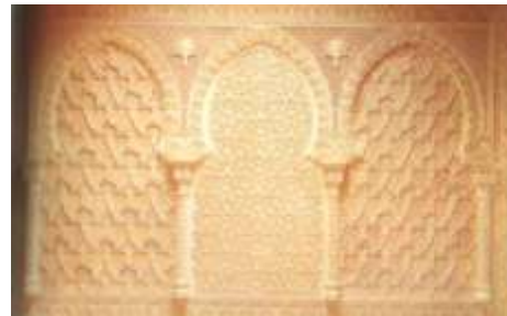
الشكل ( 12 ) يبين قوس نعل الفرس المدبب المرسوم من مركزين لدائرتين ضمن القوس . [ 7 ] ( الرسم التوضيحي للباحث ) .
