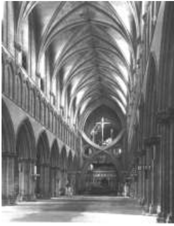
الشكل ( 38 ) كاتدرائية ويلس أ - دراسة تفصيلية للأقواس العباسية ذات المركزين في واجهة الكاتدرائية . ب - منظور داخلي في صحن الكنيسة مبين القود المتقطعة في السقف المحمولة على أقواس ذات مركزين [ 12 ] .
