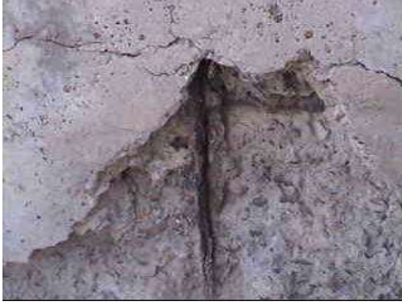
الشكل رقم (3): تآكل الفولاذ في جدار القناة.
