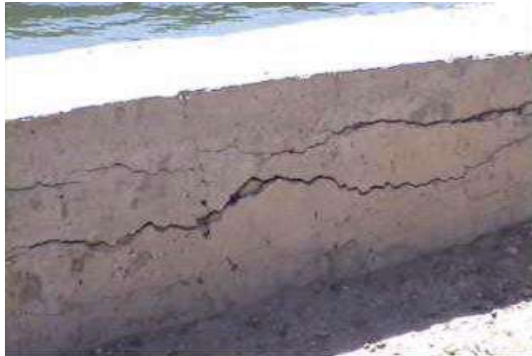
الشكل رقم (5): تشققات أفقية وتصدع في جدار القناة.
