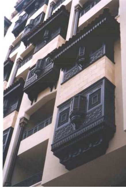
شكل(9) برج أرابيسك سكني تجاري بمدينة نصر - القاهرة يظهر فيه استخدام المشربية بأسلوب معاصر يتناسب مع ارتفاع المبنى الذي يتكون من 15 طابق حيث تظهر في الواجهة كل مشريبتين في طابقين متتاليين وكأنهما مشربية واحدة .
