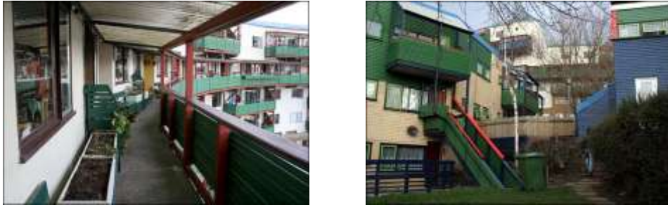
الشكل (17) الواجهات الجنوبية لمشروع حائط بيكر السكني
