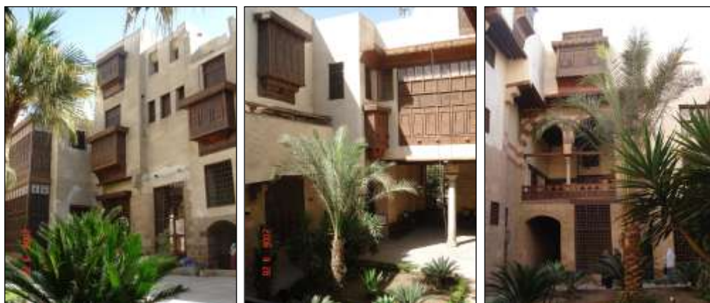
شكل (4): المعالجات المعمارية البيئية في الفراغ الداخلي في بيت السحيمي في القاهرة، ويلاحظ فيها استخدام العناصر المعمارية المتوافقة مع البيئة (الانفتاح نحو الداخل، المشربيات،....). المصدر: الباحث
