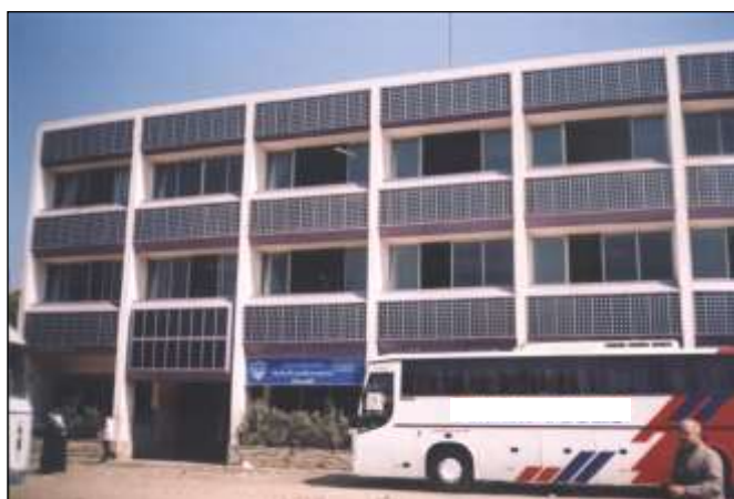
شكل (2): مركز التدريب المهني، تتكامل الخلايا الكهروضوئية مع الواجهة الجنوبية. المصدر: الباحث
