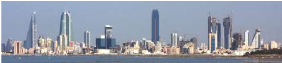
الشكل (22): تغير الملامح العمرانية وخط الأفق للواجهة البحرية لمدينة المنامة.
