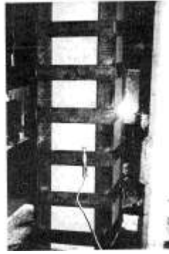
الشكل (7): تقوية الأعمدة باستخدام مقاطع فولاذية [10]
