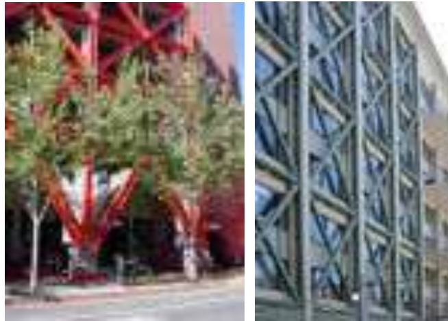
الشكل (5): تقوية بإضافة تثبيت فولاذي [9]
