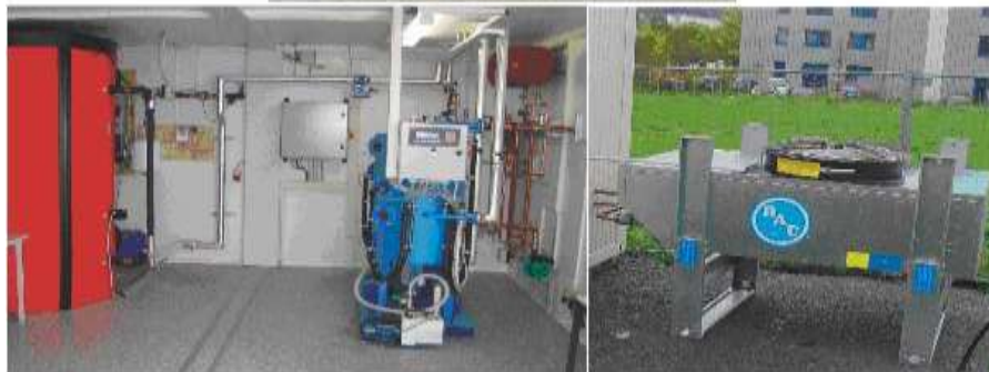
الشكل (3): منشأة تجريبية لآلة تبريد امتصاصية شمسية [13].
