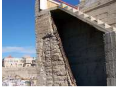
صورة جدار في جبلة (يبين تسليح طبقات البيتون وتكشف فولاذ التسليح)
