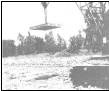
الشكل (1) الرّصّ الديناميكي باستخدام وزن ساقط على شكل بلاطة مربعة.
