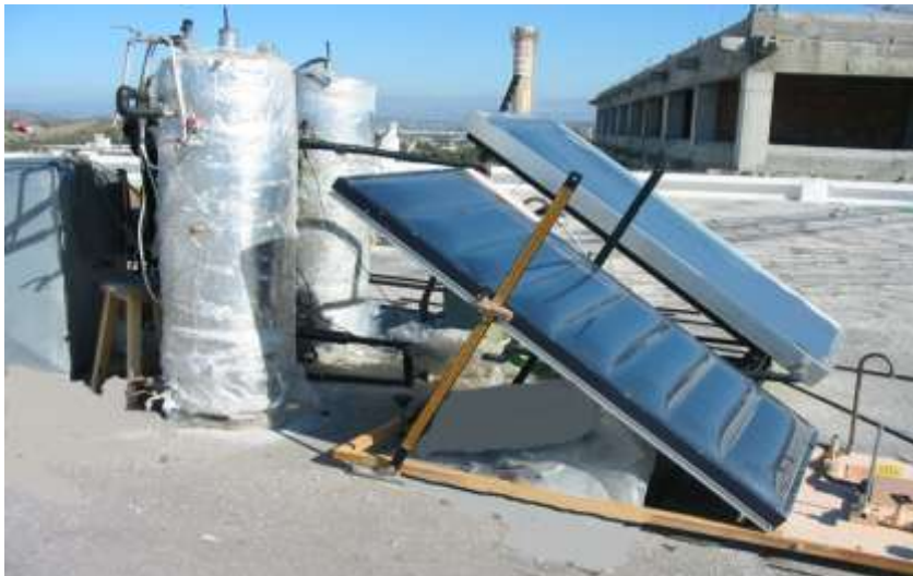
الشكل (6) نظام سخان الماء الشمسي مع كافة أجزائه مركب على سطح كلية الهندسة الميكانيكية والكهربائية في جامعة تشرين.
