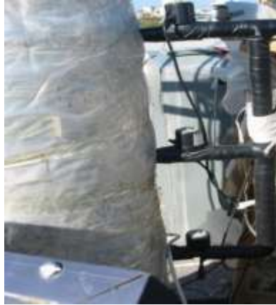
الشكل (7) الصمّامات الكهربائية المركّبة على المداخل المتعددة إلى المبادل الحراري الخارجي من نوع القميص.
